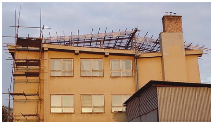
Rekonštrukcia strechy Základnej školy
