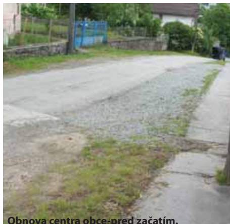
Obnova centra obce-pred začatím.
