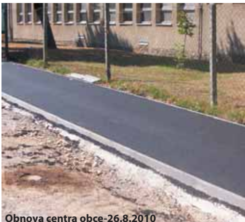
Obnova centra obce-26.8.2010
